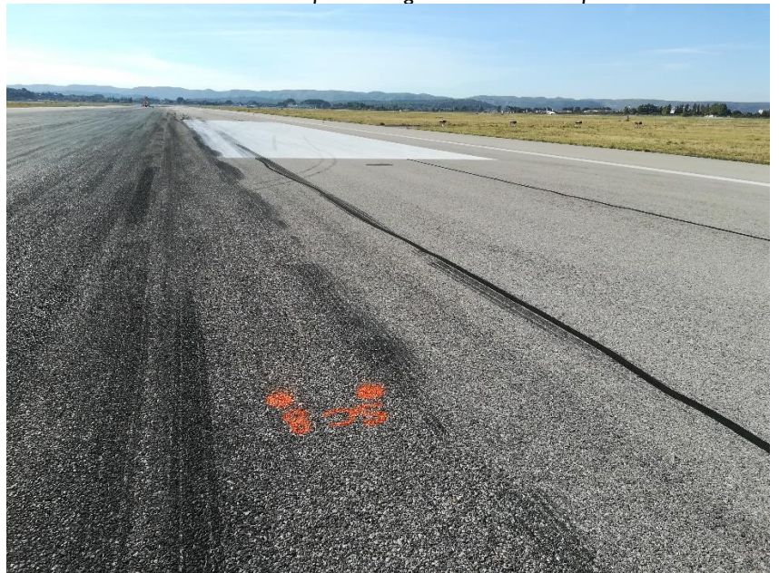
Vers SC8 : surface très rugueuse suite à perte du liant bitumineux en surface vers l'axe de la piste, en comparaison avec la bande extérieure peu affectée par le phénomène (intervention de dégomme)
