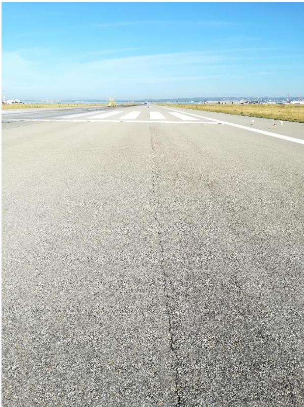
Vers SC9 : fissure longitudinale
