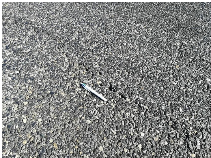
Vers SC4 : fissure avec départ de matériaux
