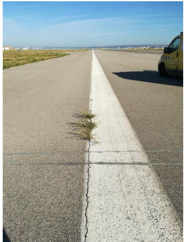
Vers SC9 : fissure longitudinale en limite piste/accotement
