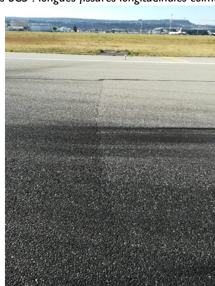
Vers SC16 : Fissure transversale
