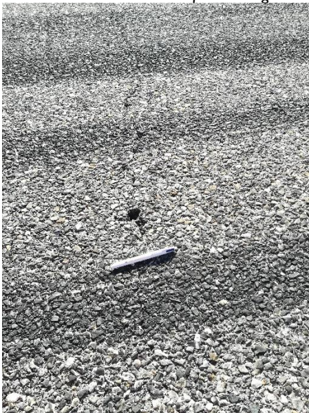
Vers SC7 : fissure avec départ de matériaux
